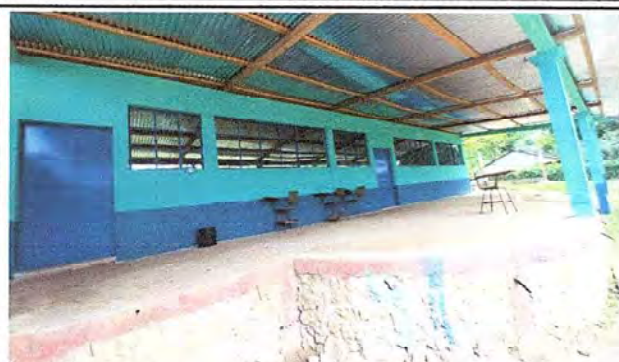
Foto 2: Colocación y finalización de ventanales con vidrios en la parte frontal de las aulas, sustitución de puertas finalizada, colocación y pintura de las puertas de metal; retoque de pintura.
