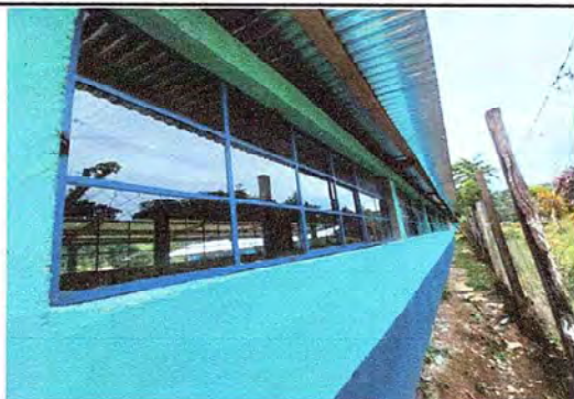
Foto 1: Finalización de colocación de ventanales con vidrios y retoque de pintura. Parte posterior.
