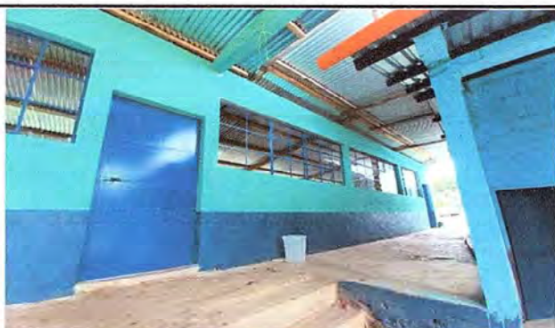
Foto 3: Colocación de tercera puerta de metal finalizada.
