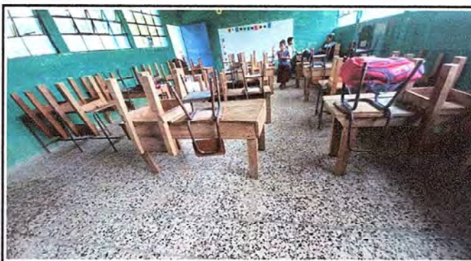
Foto 4: Finalización de colocación de piso de granito.
